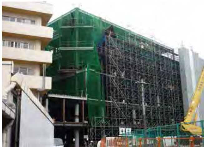
鉄骨建方完了時
