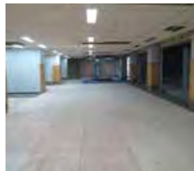
改修中のリハビリテーション訓練室
