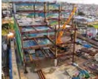
鉄骨建方中の建築現場
