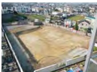
4月着工時の建築現場
